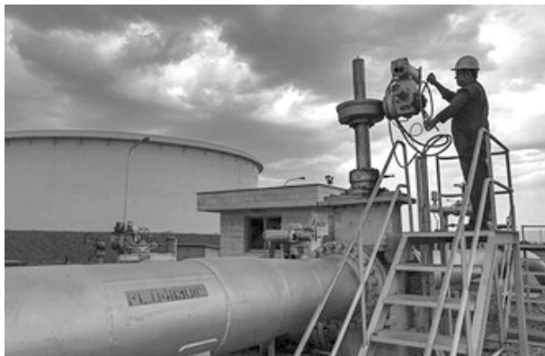
چنانچه شیرها از نوع میله بالا رونده نباشد (Stem Type) توصیه شده است به گونه‌ای انتخاب شوند تا بتوانند به روشنی و واضح موقعیت و میزان بازبودن شیر را نشان بدهند.
